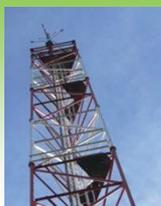
Pylône autostable de 46 m de haut, il fait partie du spectre de 53 antennes fixes destiné à contrôler les émissions d'ondes radioélectriques.
